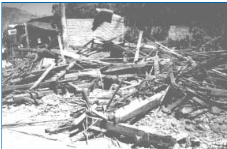
Bloqueo de vías por escombros.
