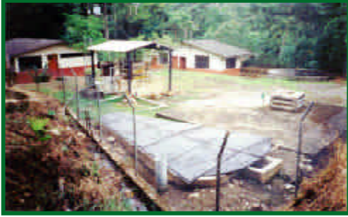
Vista panorámica de las instalaciones del sistema de la planta de tratamiento de agua potable de la población de Cháscales, provincia de Sucumbios.
