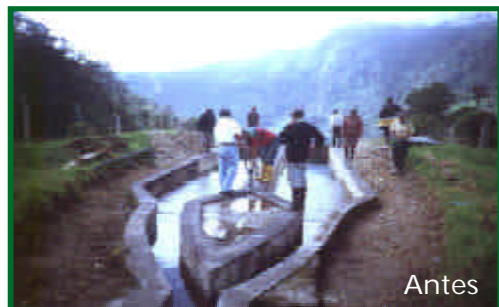
Trabajadores colocan cubiertas metálicas sobre las estructuras de captación, antes de llegar al tanque sedimentador de Cuyuja, cantón Baeza, provincia del Napo.
