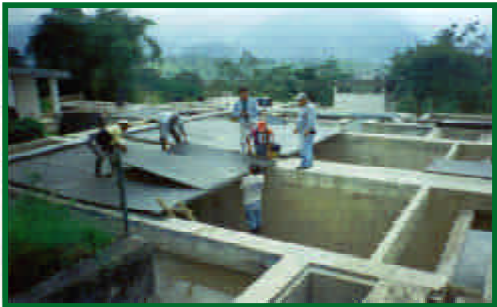
Trabajos de preparación y colocación de cubiertas metálicas sobre el sedimentador, las canaletas y filtros en la población de la parroquia de Borja, provincia del Napo.
