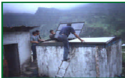
Tanque de filtración del sistema de agua potable de Oyacachi, provincia del Napo. Antes de y durante la colocación de las cubiertas o protecciones.
