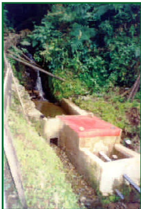
Estructura de captación y desarenador.
