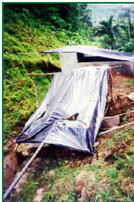
Vista del sedimentador, el filtro y las cubiertas de plástico colocadas sobre las estructuras.
