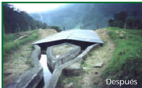
Trabajadores colocan cubiertas metálicas sobre las estructuras de captación, antes de llegar al tanque sedimentador de Cuyuja, cantón Baeza, provincia del Napo.
