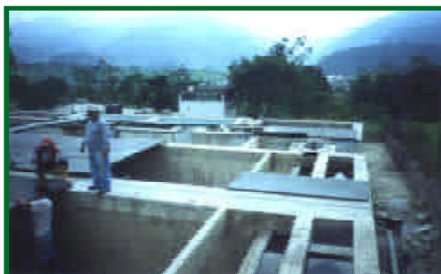
Trabajos de ubicación de la cubierta metálica en los tanques de sedimentación en la población de Baeza, Cantón Baeza, Provincia del Napo.
