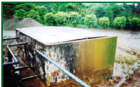
Estructura de los tanques desarenadores y filtro con protección de cubiertas metálicas de la planta de tratamiento de agua de Las Palmas, cantón El Chaco.
