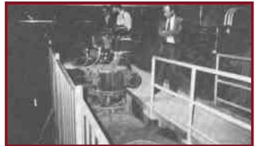
Figura 103. Válvula de corte activada por sismos en Yokosuka, Japón.
