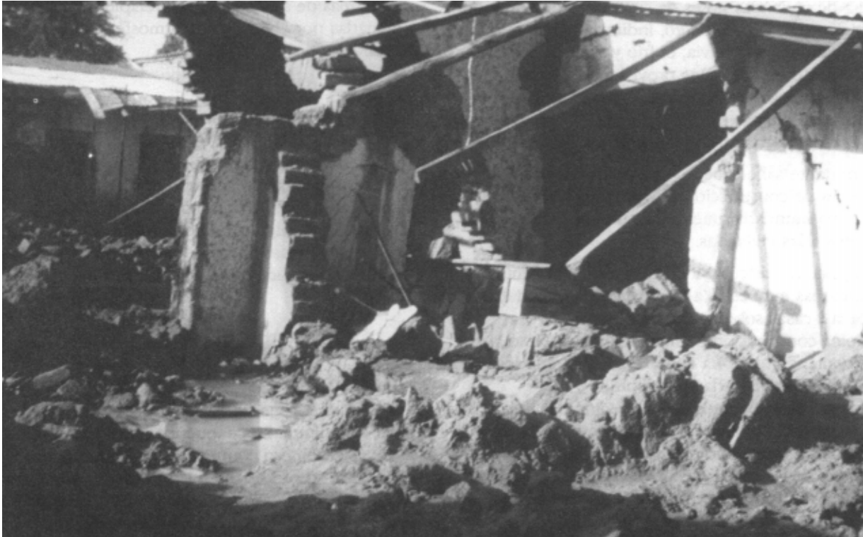
Figura 3.2. Casas de adobe destruidas por inundaciones en el norte del Perú, 1983.
