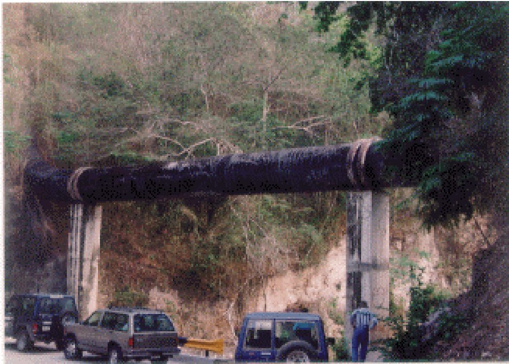
Foto 5.1 Puente (quebrada Las Palmas) con acceso directo a la carretera
