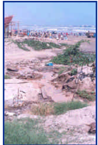
Foto 13. Descarga de aguas servidas e industriales en el alcantarillado de aguas de lluvias. Sector Los Astilleros-Manta (febrero de 2000).
