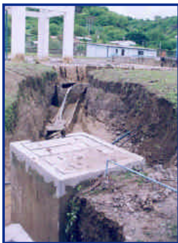
Foto 20. Se aprecian en el cauce del canal El Zapallo las tuberías de químicos y cámaras de válvula (febrero de 1998).
