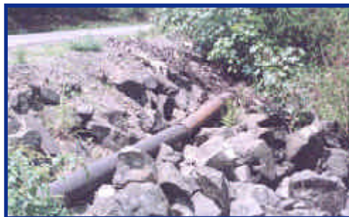
Foto 9. Tubería instalada y protegida por muros de escollera. Sector Emaús (febrero de 2000).
