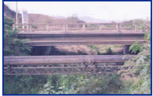
Foto 2. Ubicación y paso aéreo de las tuberías reparadas por la Empresa de Agua Potable y Alcantarillado de Manta. Puente Río de Oro, Portoviejo, Manta (febrero de 2000).
