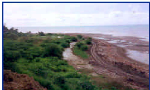
Foto 53. La imagen muestra la carretera por donde cruza la tubería y el peligro constante del mar (julio de 1999).
