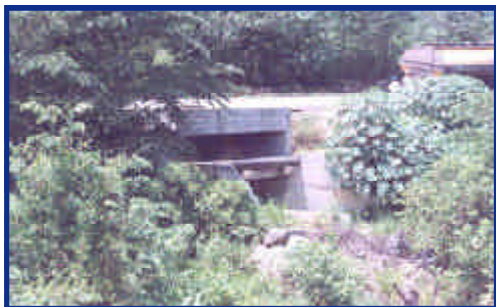
Foto 8. Acueducto reparado. Se observa la tubería anclada sobre una alcantarilla. Sector Emaús (febrero de 2000).
