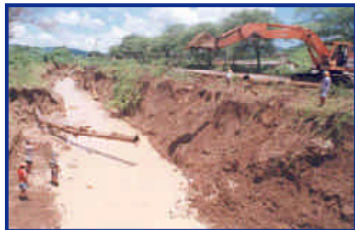
Foto 7. En este sitio la tubería recuperada se instaló, desplazada 100 metros de su eje original. Sector Emaús (abril de 1998).
