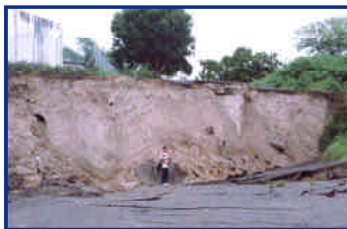
Foto 17. En la esquina superior izquierda se aprecian los tanques agua de potable de 5.000 m 3 y 1.600 m 3 . Loma Blanca (marzo de 2000).
