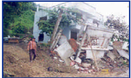
Foto 32. Se observa el deslizamiento de la ladera y la destrucción de viviendas. Sistema de Bahía. Sector: línea de conducción a Bahía, km 8. Octubre de 1998.
