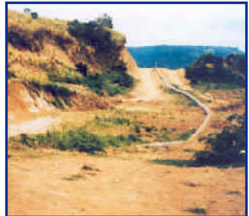
Foto 38. Tramo en riesgo de fallas en la línea de conducción a Esmeraldas (octubre de 1998).
