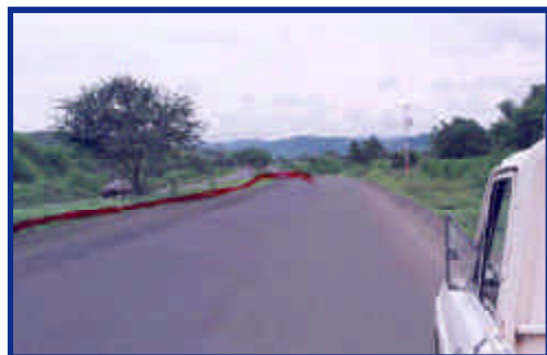
Foto 6. La zona resaltada indica el sector del parterre , lugar en que se ubica la tubería actualmente. Entre Disensa y la estación de bombeo Río de Oro (febrero de 2000).
