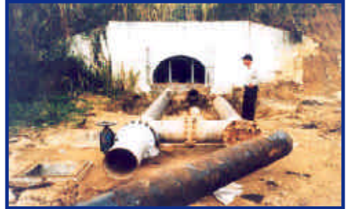
Foto 44. Salida del túnel 1 cuando se estaba reparando la línea (octubre de 1998).
