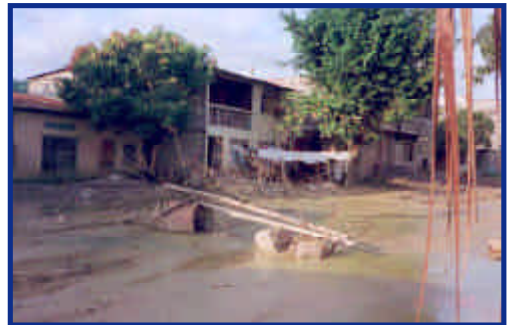
Foto 57. Sedimentos producidos por la erosión del suelo que ayudaron a destruir el sistema de alcantarillado (marzo de 1998).
