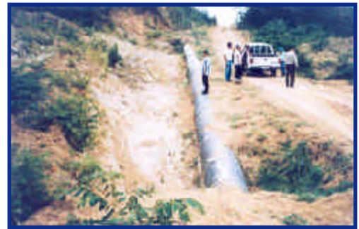
Foto 37. Tubería reparada en la línea de conducción hacia Esmeraldas. Obsérvese el espacio a la izquierda del tubo para recibir y posteriormente remover material de deslizamientos (octubre de 1998).
