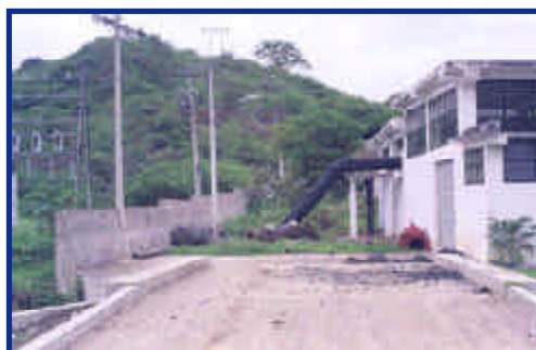
Foto 10. Muros perimetrales de hormigón para evitar inundaciones en la estación de bombeo Río de Oro (febrero de 2000).
