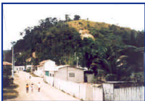
Foto 51. Ladera sobre la cual se ubica el tanque de Atacames. Se observan la fuerte pendiente y los deslizamientos existentes. En la parte inferior se muestran las viviendas que se verían afectadas ante el riesgo de fallar la estructura (octubre de 1998).
