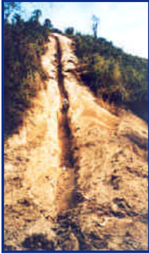
Foto 56. Tramo con alta pendiente y suelos inestables en la línea de conducción hacia Camarones-Achilube (octubre de 1998).
