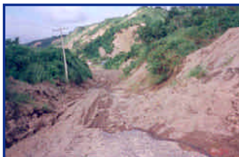
Foto 55. Tramo por donde cruza la tubería (agosto de 1999).
