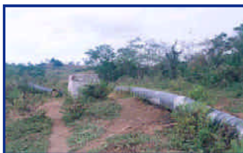
Foto 42. Tubería recuperada y soldada. Se observan el anclaje y la tubería destruida (febrero de 2000).
