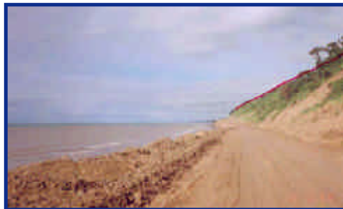
Foto 54. Resaltado, el tramo por donde se cambió la ruta de la tubería para evitar que fuera socavada por la marea (julio de 1999).
