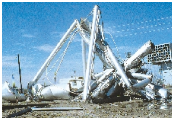
Tanque de agua "resistente a terremotos" destruido después de un terremoto
