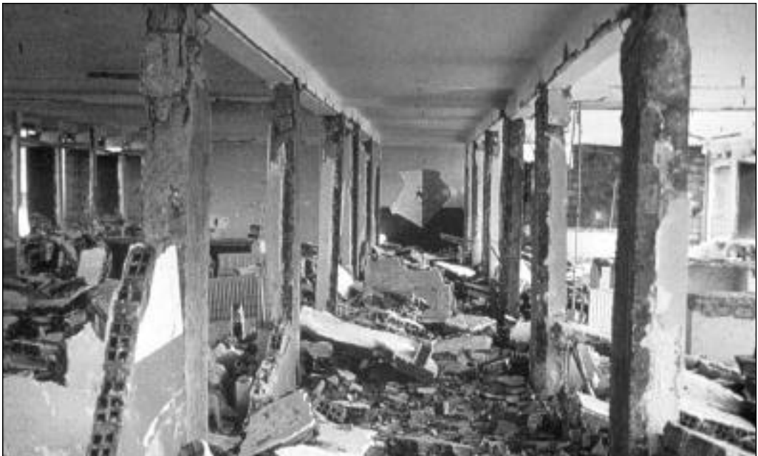
Fotografía 24. Muros destruidos por flexibilidad de la estructura
