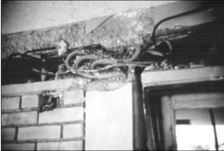
Fotografía 18. Efecto de columna corta
