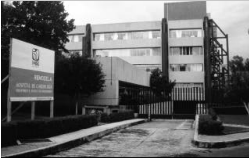
Fotografía 12. Hospital de Cardiología del Instituto Mexicano del Seguro Social que fue reforzado usando pórticos contrafuerzas luego del sismo de México 1985.
