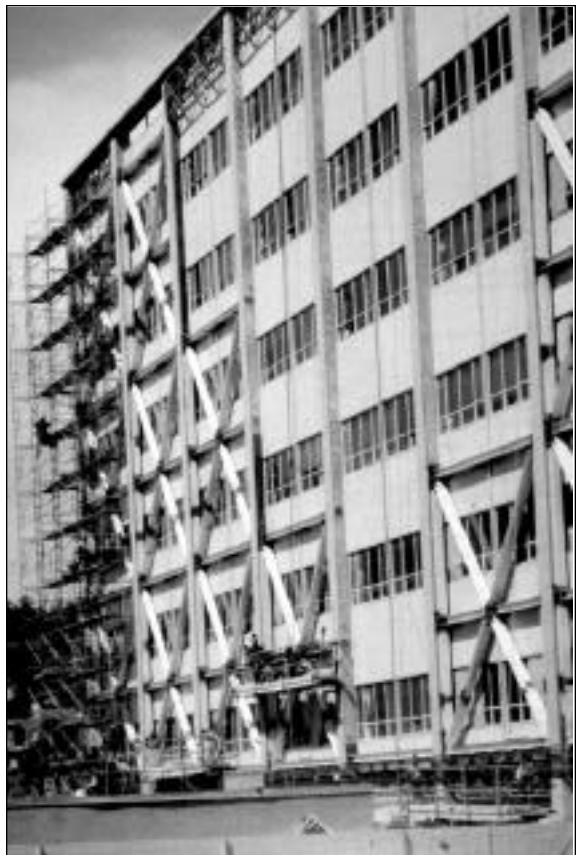
Fotografía 13. Refuerzo con diagonales
