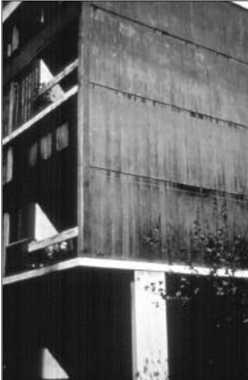
Fotografía 10. Interrupción de muro estructural en la planta baja
