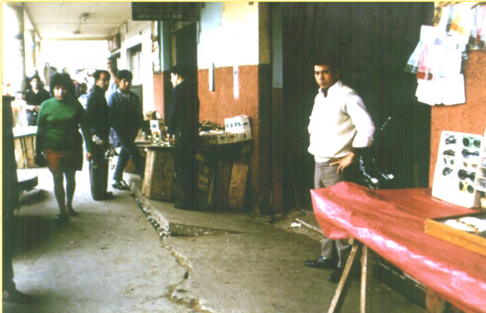
Licuación de Suelos en Chimbote, Perú. Sismo de 1970
