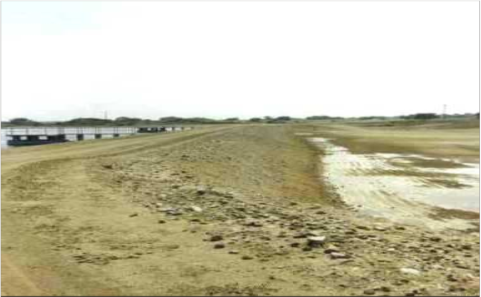
Laguna de San José en Chiclayo, conformadas con suelos moderadamente dispersivos
