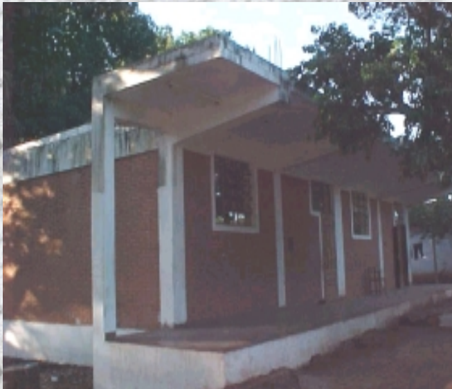
Reconstrucción de Escuela - Itá
