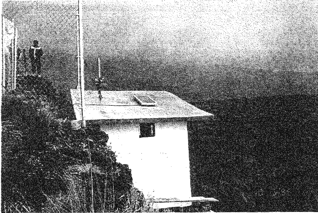
Figura 32. Caseta de protección definitiva en la estación Chipiquixtle, Mex. (PPX, PIX) construida conjuntamente por el Cenapred y la Unidades Municipales de Amecameca, Autlautla, Ayapango, Ecatzingo, Ixtapaluca, Tenango, Tepedixpa y Ozumba, mayo 1995.
