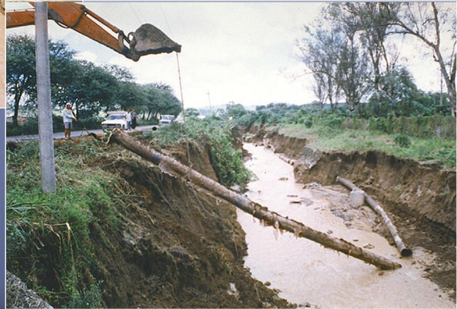
*Aprovechar el trazado de una carretera y la presencia de puentes para el tendido de tuberías incrementa la vulnerabilidad de las mismas*
