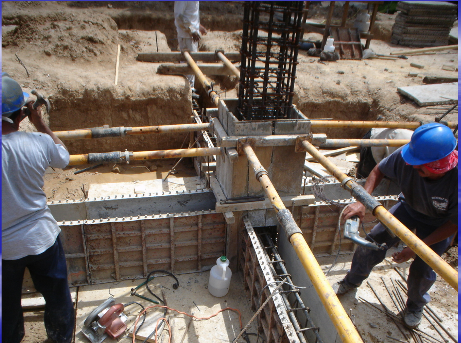
ARMADURIA EN FUNDACIONES Y COLUMNAS
