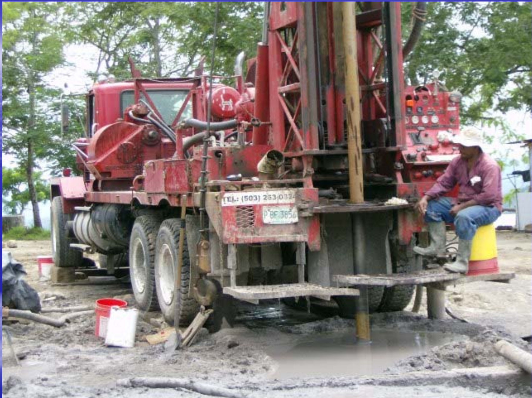
PERFORACION DEL POZO PARA AGUA POTABLE
