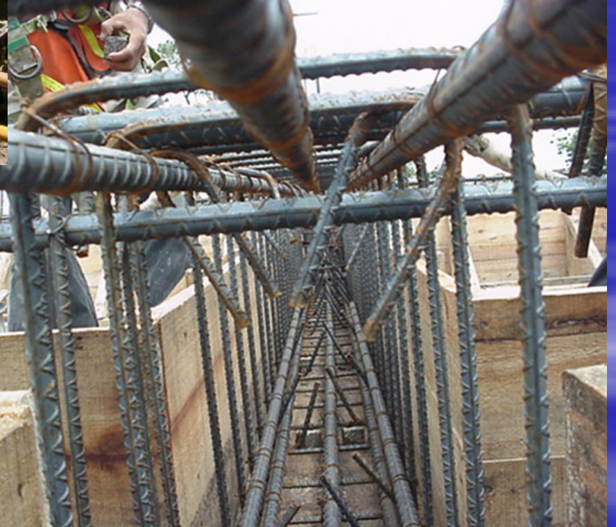
ARMADURIA DE REFUERZO PARA COLUMNAS Y FUNDACIONES
