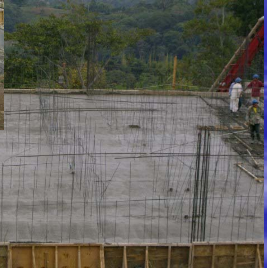
LOSA DE ENTREPISO COLADA
