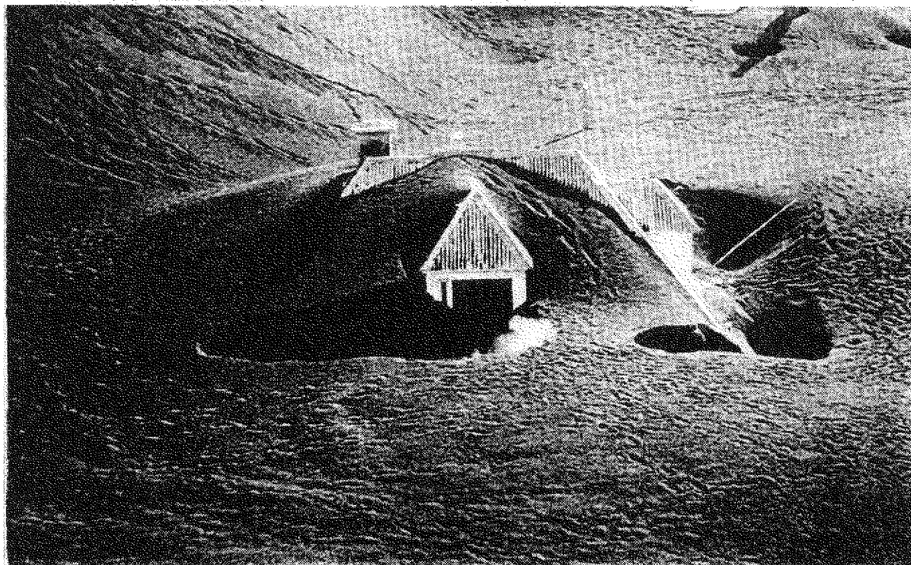
FIGURA 13. Casa semienterrada en Heimaey por caídas de ceniza: erupción del Eldfell, Heimaey, 1973. El techo está todavía intacto, debido a su construcción sólida y su fuerte inclinación
