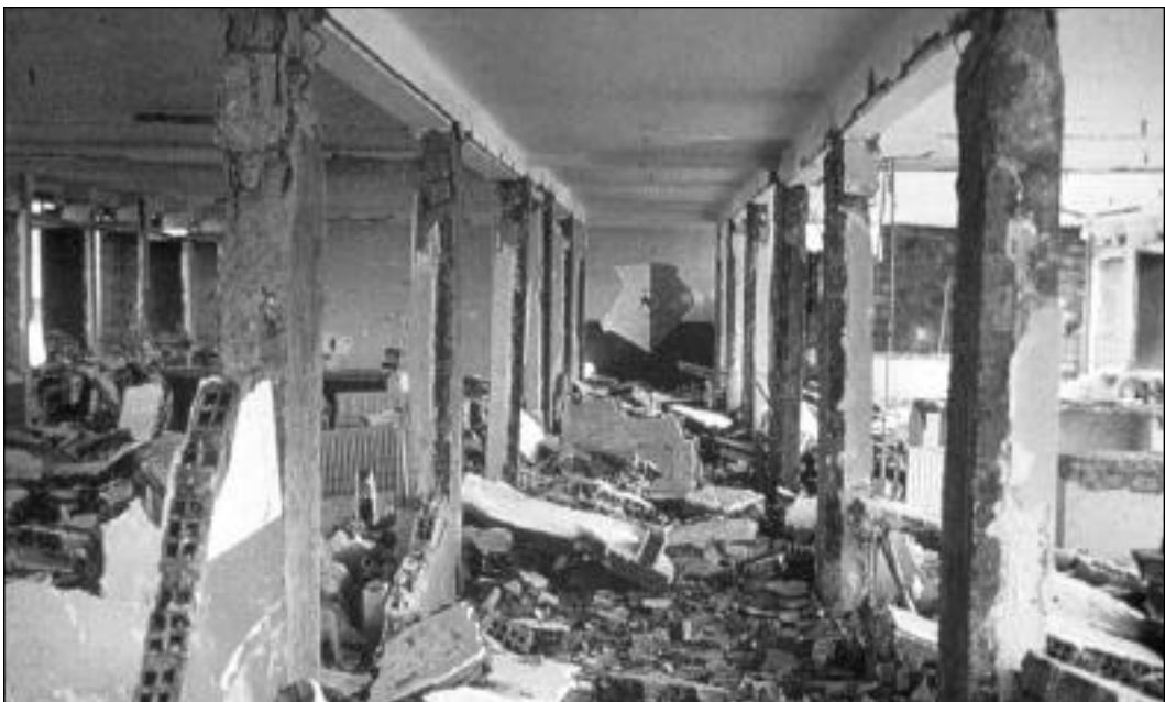
Fotografía 24. Muros destruidos por flexibilidad de la estructura
