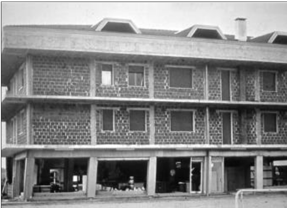
Fotografía 9. Falla en planta baja por piso suave
