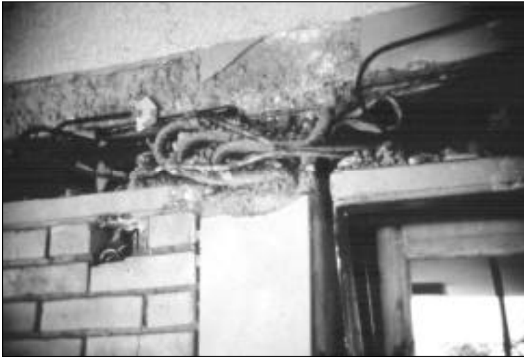
Fotografía 18. Efecto de columna corta
